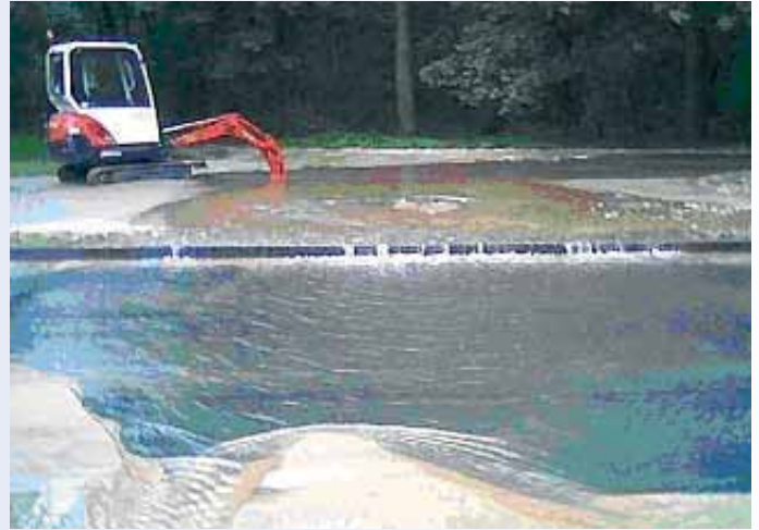
Die Wassermassen erschweren die Arbeit mit dem Mobilbagger
