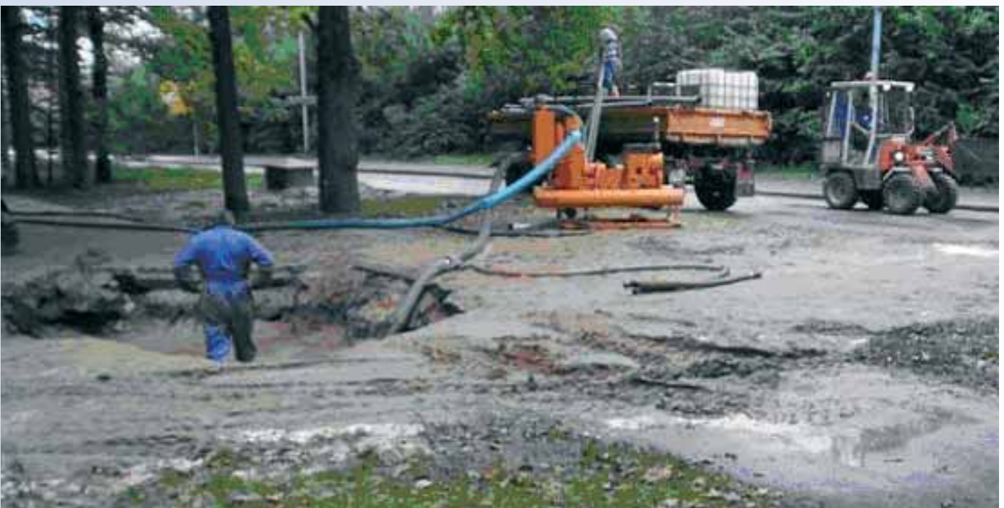
Selbst Grundwasserabsenkung wird benötigt um die Wassermassen zu „bändigen“
