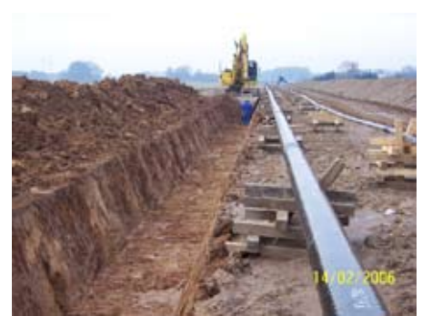
Erstellung Rohrleitungsgraben
